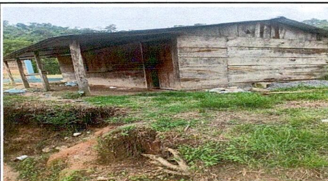
Foto 3: Mejoramiento de cocina tipo portico
