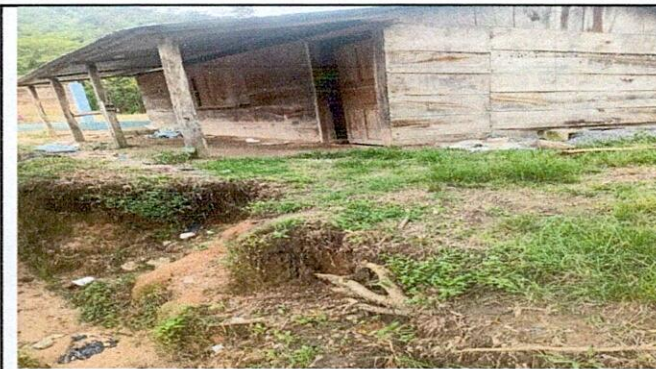
Foto 4: Mejoramiento de cocina tipo portico
