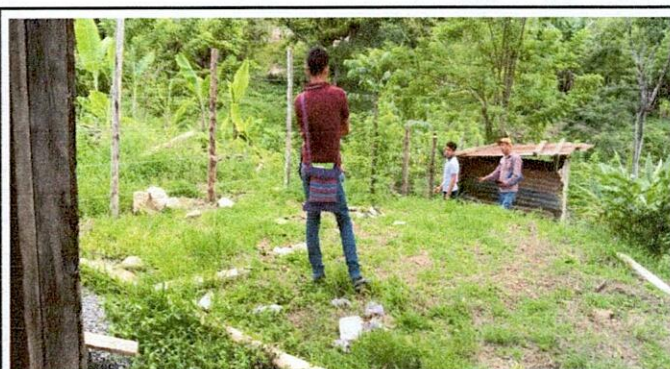
Foto 4: Mejoramiento de sanitarios y migitorio con pared de block
